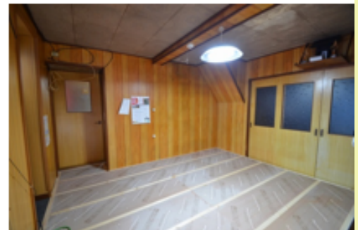
礼文町モデル事業断熱改修工事例(床断熱)
