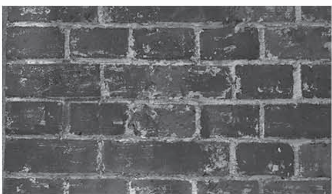
イギリス式とはレンガの長い面と短い面を交互に積み重ねる
