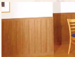
腰壁パネルを貼って、ネコの 掻き傷を軽減
